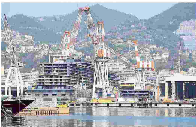
Il cantiere di Fincantieri a Sestri Ponente
