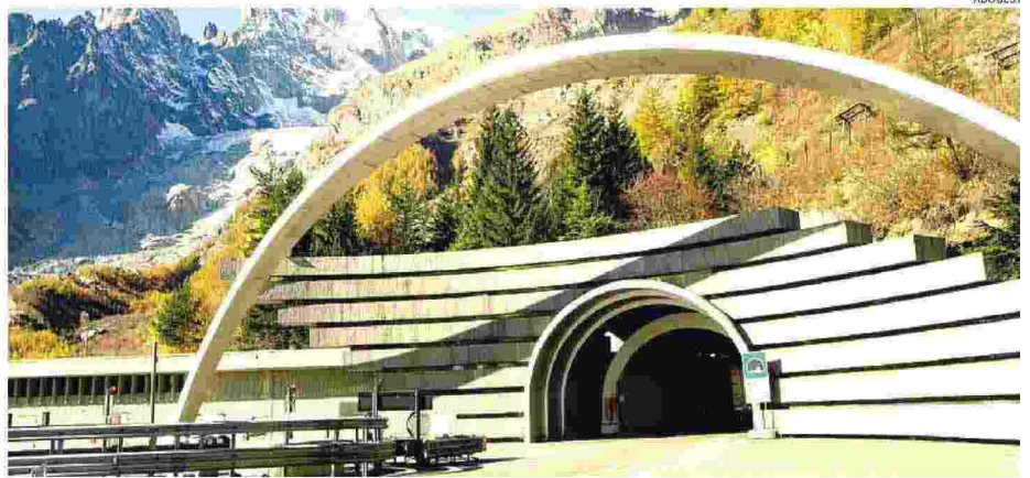
Tra Italia e Francia. L'imbocco del traforo del Monte Bianco: il tunnel resterà chiuso per Tir e auto fino al 18 dicembre 2023
