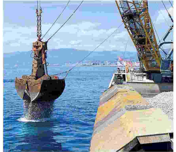
Prosegue la posa della ghiaia sui fondali per costruire la nuova Diga
